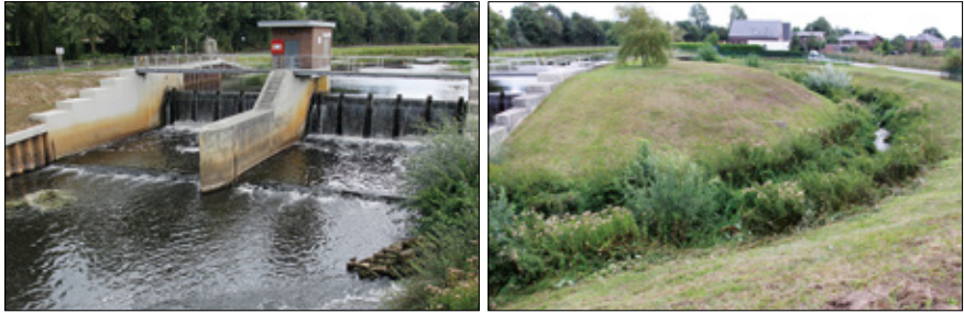
Figuur 2.47 Dinkelstuw Neuenhaus.
