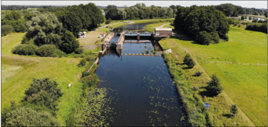
Figuur 7.6 Stuw De Haandrik, gezien van de stroomafwaartse zijde.
