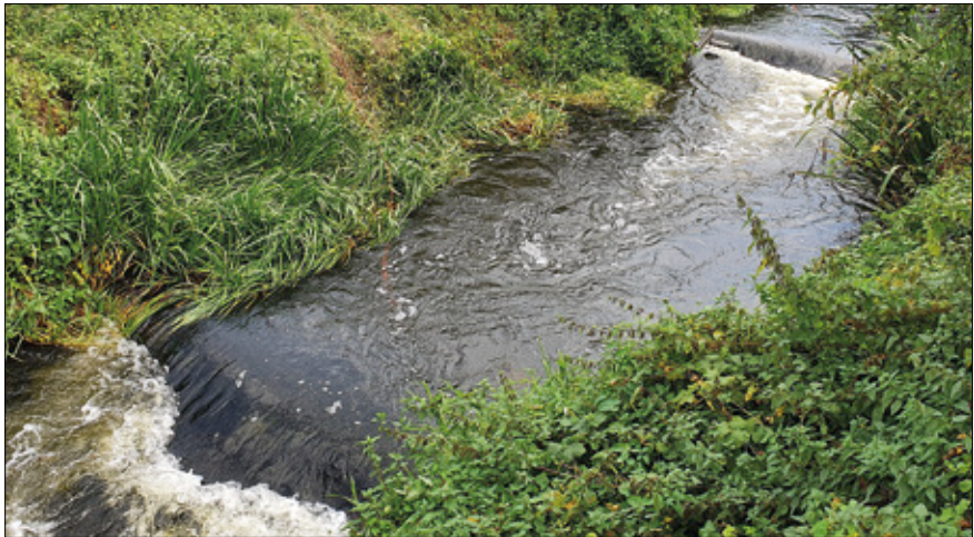
Figuur 5.1 De treden van de vispassage Vechterweerd.
