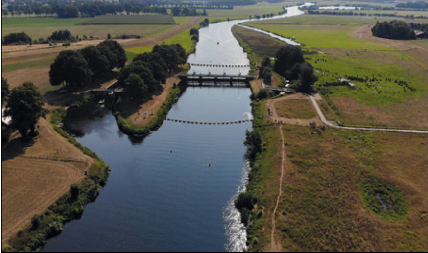
Figuur 71 Stuw Vechterweerd, gezien van de stroomafwaartse zijde.
