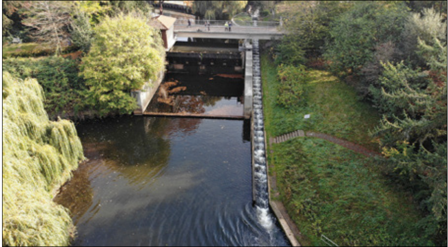
Figuur 7.7 Nordhorn - Ölmühlen, stuw en vispassage. Gezien van de benedenstroomse zijde.
