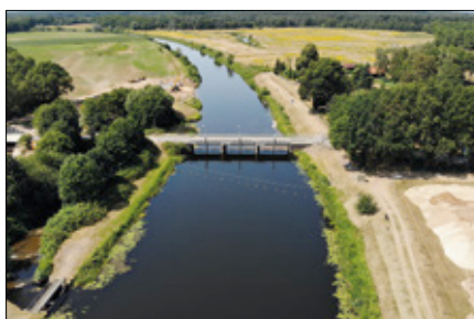
Figuur 2.15 Stuw en vispassage Junne.
